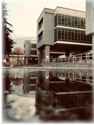
2. Batuhan FİDANBOYLU Mimarlık Bölümü
