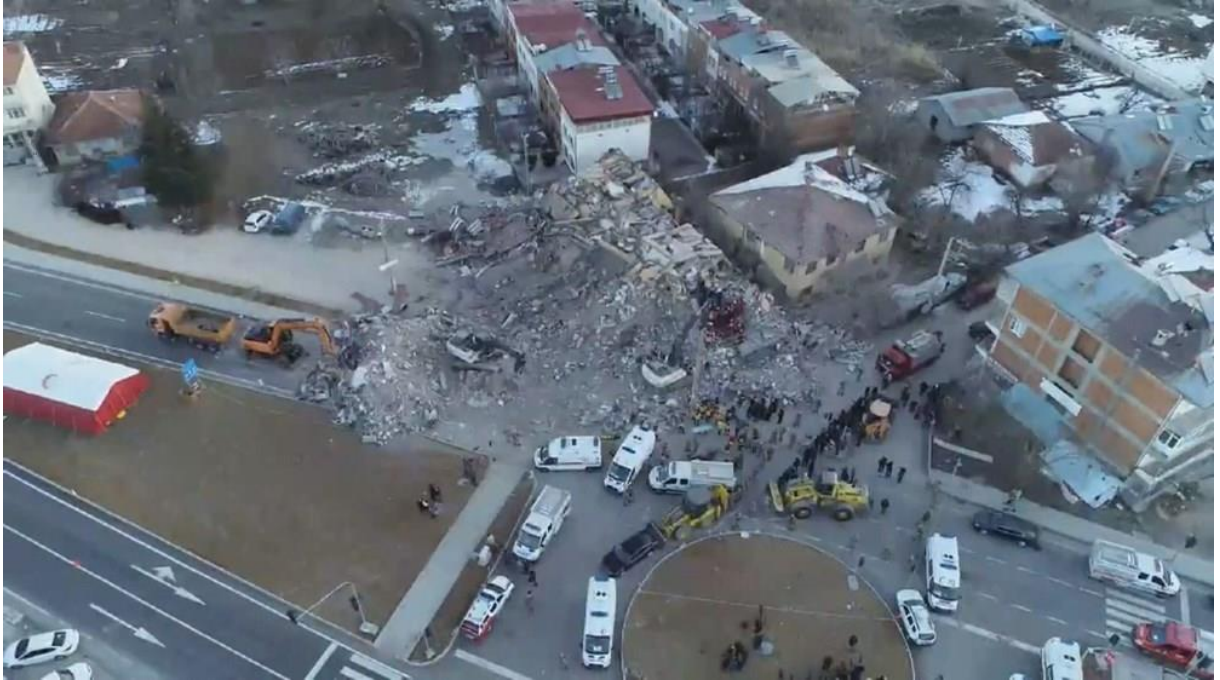
Şekil 2. Elazığ'ın Gezin ilçesinde yıkılan ve 3 kişinin hayatını kaybettiği 6 katlı Mavi Göl Apt. (Deprem öncesi ve sonrası). Binanın 2011 Van depremi sırasında hasar aldığı, hafif hasarlı raporu verildiği öğrenildi.
